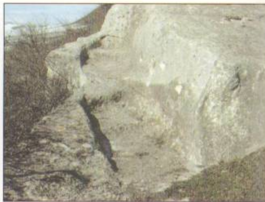
Նկ. 16. Տիգրանակերտ, կիսակլոր աշտարակի ժայռափոր հիմքը
