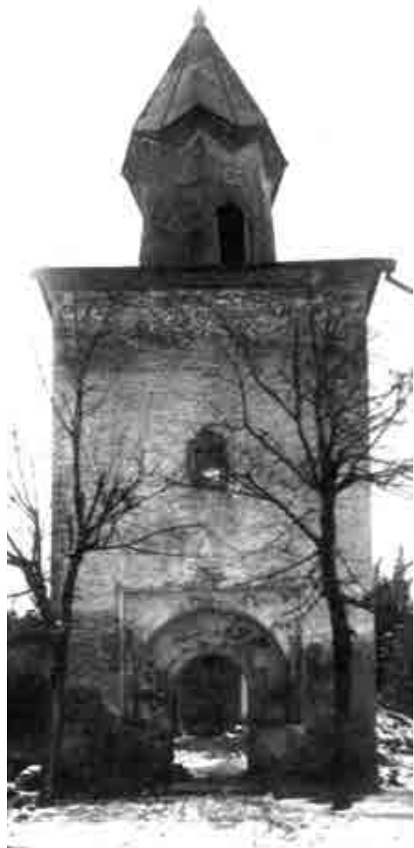
Խոջիվանք. Ծիրանավոր Սբ. Աստվածածին վանքը հարավ-արևմուտքից (լուս.՝ 1910-ական թթ.) և զանգակատունն արևմուտքից (լուս.՝ 1936 թ., քանդելուց ընդամենը շաբաթներ կամ զույգ օրեր առաջ)
