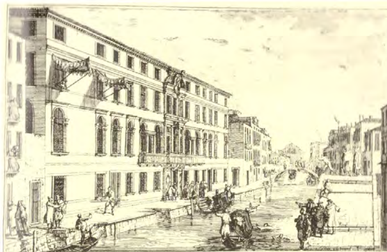
PALAZZO ZENOBIO SOPRA IL RIO DEL CARMINE Architettura di Antonio Gaspari
