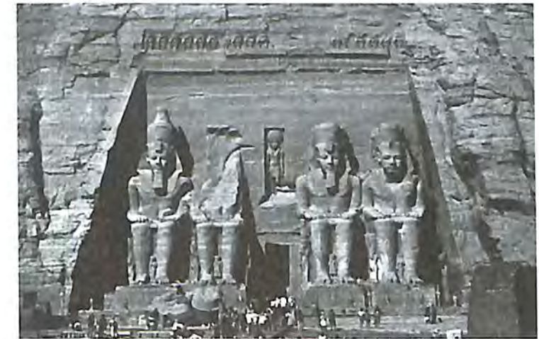
Ռամզես II-ի տաճարի ճակատը Աբուսիմբլեյում (Ք. ա. մոտ 1250 թ.): 1964–66 թթ. Ասուանի ամբարտակը կառուցելիս այս տաճարը 1036 մեծ կտորների սղոցվեց և 68 մ վեր տեղափոխվեց:
