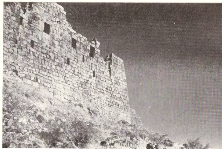
Նկ. 15. Միջնաբերդի հարավային պատը՝ Բաղրատունյաց շրջանին հատուկ շարվածքով:
