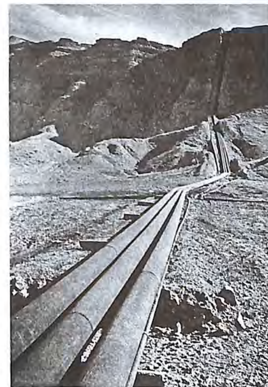
Иранский трубопровод (снимок сделан в 1940г.).
