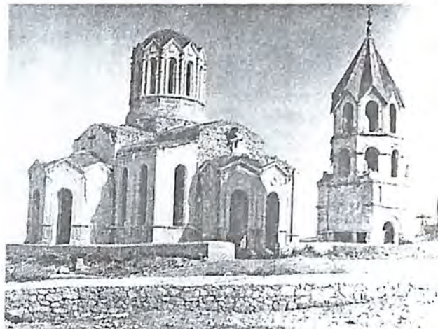
Цекровь Казанчепи в Шуши (с обрушенным куполом), переоборудованная под складское помещение (снимок 1980г.).
