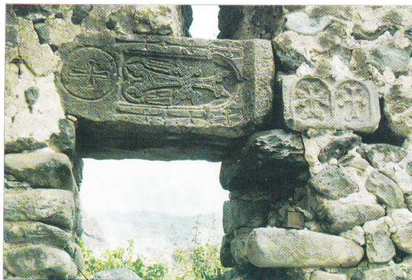
• Хачкар и фрагменты церкви, использованные азербайджанцами в качестве строительного материала
