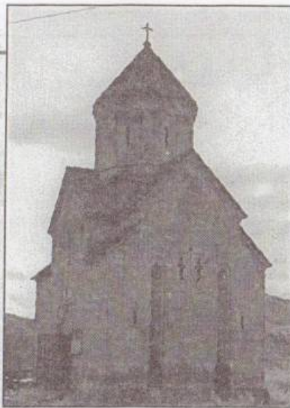
Վայոց Ձորի մարզ. գ. Արենի, Սբ. Աստվածածին եկեղեցի (1321 թ.): Նախագծի հեղինակ՝ Հրաչյա Գասպարյան, շին. ղեկավար՝ Արտաշես Հովսեփյան, (վերականգնվել է երկու փուլով՝ 1968-1977 թթ. և 1992-1997 թթ.): Vayots Dzor marz, vil. Areni, church St. Astvatsastin (1321). Project director – Hrachya Gasparyan, head of the construction – Artashes Hovsepyan (reconstructed in two stages, 1968-1977, 1992-1997).
