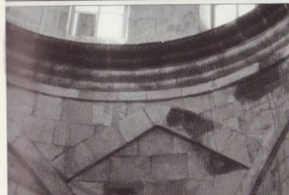
ճեղձակ եկեղեցու թմբուկը ներքուստ, առագաստը և հատված եկեղեցու վեղարի ծածկասալերից
