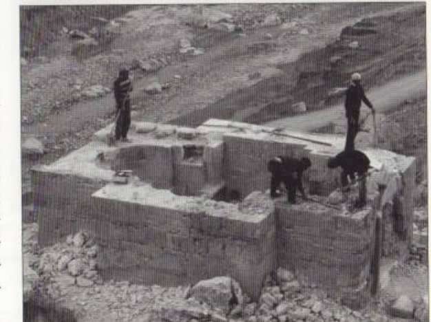
Ծործորի վանքի եկեղեցին նոր վայր փոխադրելու նպատակով քանդելու պահին (լուս.՝ Ճարտ. դր. Արմեն Հախնազարյանի, 1985 թ.)
