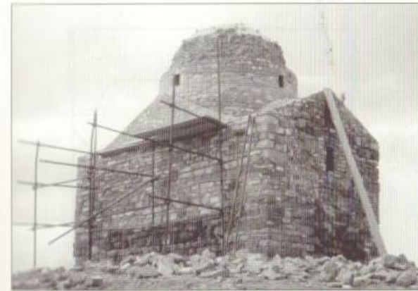
Սր. Սանդուխտ մատուռը 1992 թ. կատարված կամայական վերականգնումից հետո (միանավ հորինվածքին հավելվել է նորարարյա գմբեթ) և հավելվածը քանդելուց հետո (լուսանկարները՝ Արմեն Գալստյանի)
