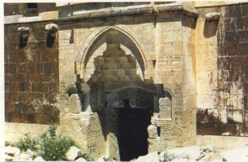
Վերջին տարիներին ջարդել են շքանուտքի քարերը, որը կարող է նրա հիմնական կործանման պատճառը դառնալ: سنگهای ورودی اصلی در سالهای اخیر خرد شده که میتواند باعث ویرانی تمامی سردر شود. A part of main entrance stones moved out recently which can destroy all entrance
