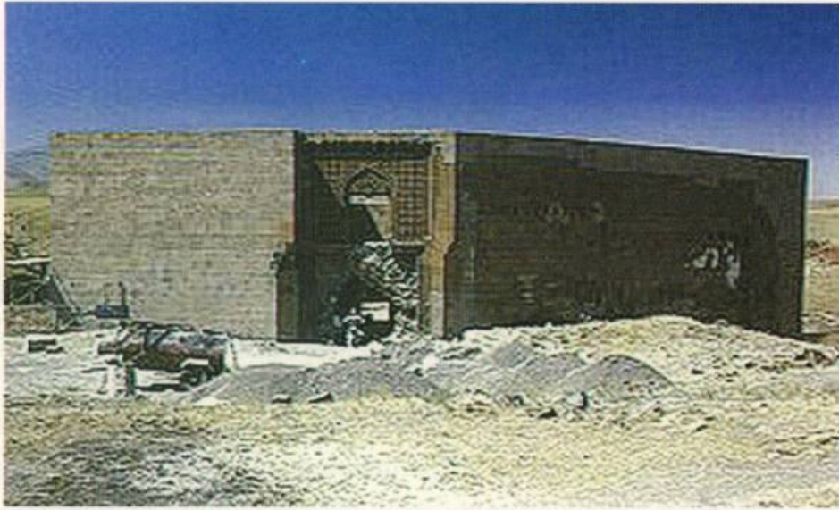
Պալատի գլխավոր մուտքը եւ նրա կողքերի պատերը 1999 թականի նորոգութիւններից յետոյ ուր չի կարելի գտնել որեւէ հետք հին մասերից: نمای خارجی و ورودی اصلی قصر بعد از مرمت که قسمتهای قدیمی بنا کاملاً پوشیده شده است Main entrance and outside wall after repairing.
