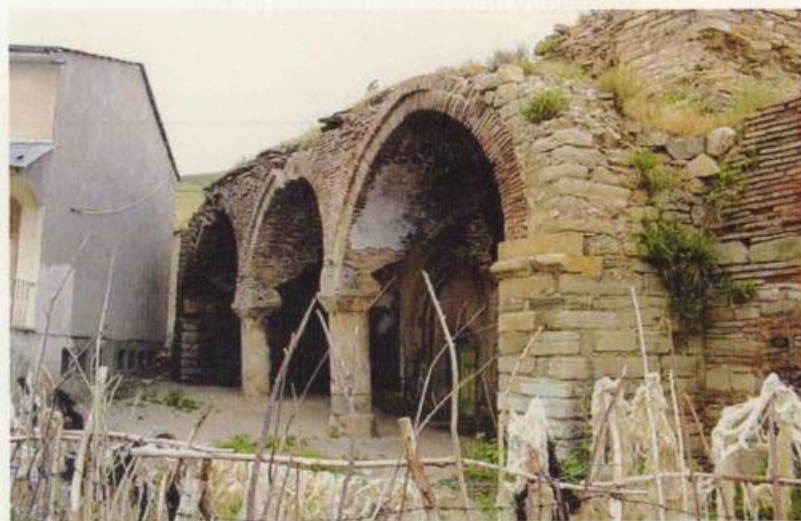
Վանքի կամարաւոր նախամուտքի ներկայի վիճակը: Կործանւել է նրա զլխի զանգակատունը եւ աւերւել կամարների որոշ մասեր իսկ նրա կողքին կառուցւել է գիւղի մզկիթը վանքի քարերով: وضعیت ورودی ستوندار دیر که ناقوس خانه بالای آن و قسمتهائی از ستونها ویران شده و در کنار آن مسجد با سنگهای کلیساهای ویران شده دیر ساخته شده است Present situation of entrance which demolished and the bell house destroyed completely. A mosque built close to entrance by the stones of churches.
