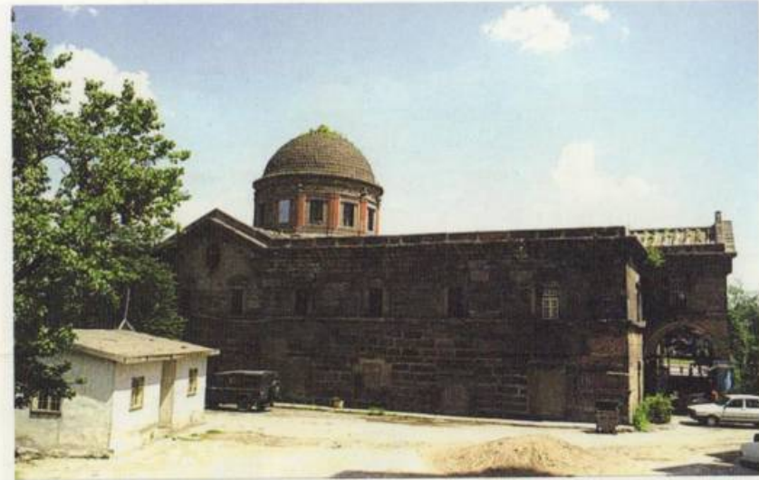
Կեսարիայի հայկական եկեղեցիներից մեկի արտաքին տեսքը: نمای خارجی یکی از کلیساهای ارمنه شهر قیصریه در حال حاضر One of Armenian churches in Kayseri city now.
