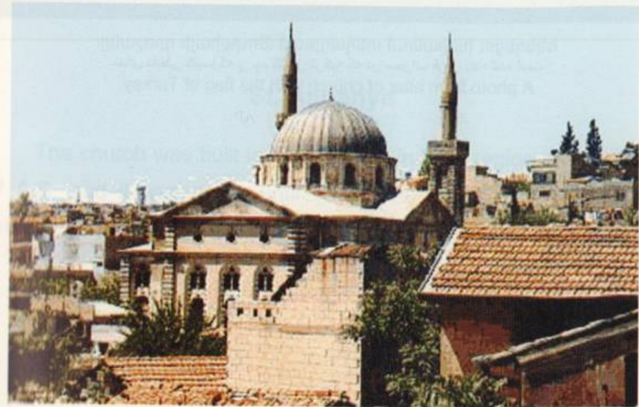
Եկեղեցու ներկայիս վիճակը: Աւերել են զանգակատունը իսկ եկեղեցու վրայ կառուցելով երկու մինարեթներ դարձրել են մզկիթ: وضعیت فعلی کلیسا؛ ناقوس خانه آن ویران و دو مناره بر روی آن ساخته شده است Present situation of church. The bell house destroyed and two minarets built on it.
