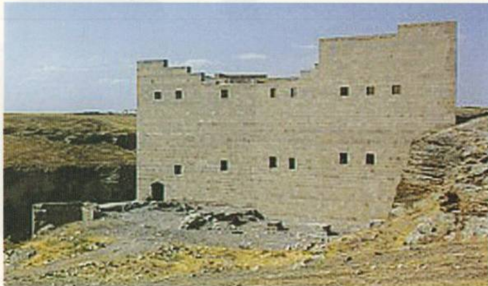
12-րդ դարւայ հին պատերի վրայ շարւած նոր քարեր, որոնց միջոցով ծածկւել է բոլոր հայկական հետքերը: تمامی دیوارهای مربوط به قرن 12 میلادی با سنگهای جدید پوشانده شده و حجاریهای مربوط به از امنه محو شده است. All walls of 12 th century covered by new stones and disappeared Armenian signs.
