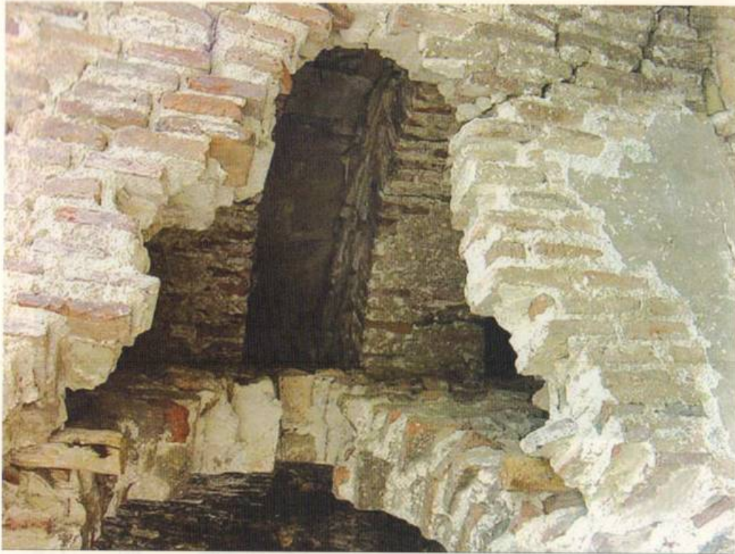
Վերջերս կատարած աւերածութիւններ կամարաւոր սրահի ծածկի մէջ. تخریب های سالهای اخیر Demolishment made during last years
