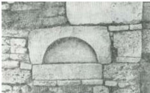
Оконный перемычный камень с ложной аркой, обнаруженный в кладке жилого дома
