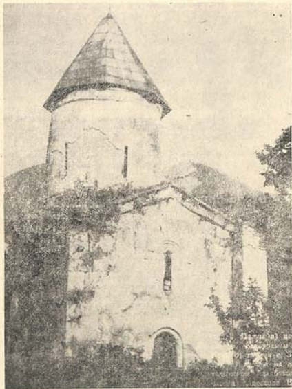
Рис. 1. Западный фасад церкви с. Киш.
