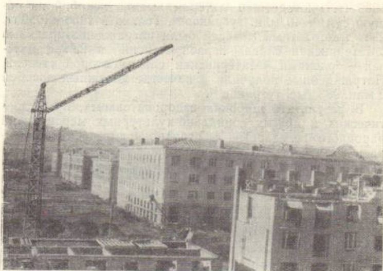
Строительство домов в Северо-Западном районе Улан-Батора
