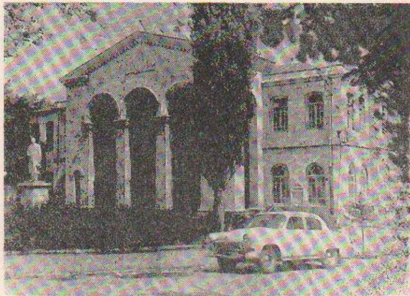
Здание драматического театра им. М. Горького в Степанакерте.
